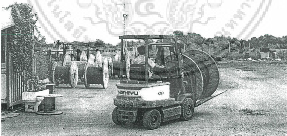
รูปที่ 4.3 (ข) การติดตั้งสายเคเบิลใยแก้วนำแสงในสถานที่ทดลอง
