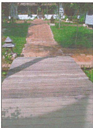
ภาพที่ 2.157 ส่วนทางเดินเท้าและสะพานไม้ที่เชื่อมส่วน ต่างๆของโครงการ
