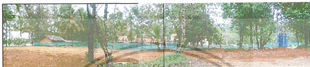
ภาพที่ 4.2 แสดงพื้นที่ติดต่อด้านทิศเหนือติดกับพื้นที่ส่วนบุคคลโครงการเขาช้างวิสุทธ ( กำลังดำเนินการก่อสร้าง )
