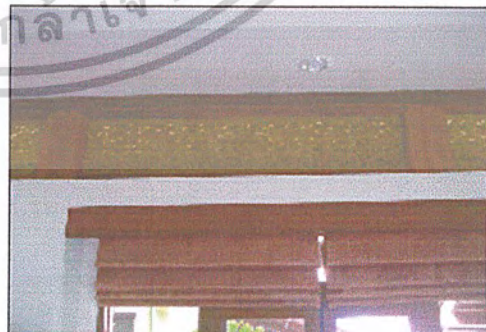
ภาพที่ 2.165 ภาพส่วนชองลมซึ่งมีการ ตกแต่งด้วยแผ่นไม้แกะสลักปิดทับด้วย กระจกใสอีกชั้นทำให้กันยุง
