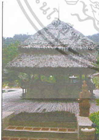
ภาพที่ 2.102 แสดงลักษณะอาคาร ที่เป็น บาริมสระซึ่งเป็นอาคาร โปร่งหลังคามีการซ้อนชั้น
