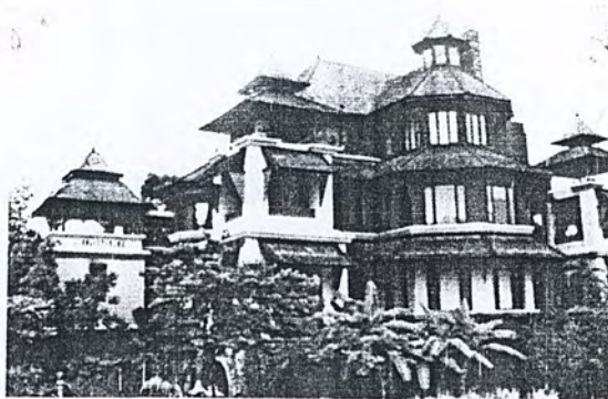
ภาพที่ 2.30 แสดงลักษณะอาคาร Regent Residence
