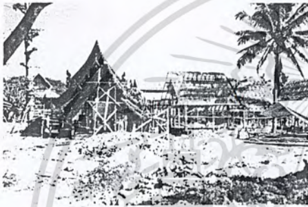
ภาพที่ 3.35 ลักษณะกลุ่มอาคารแบบ VILLA HOUSE. ทิศตะวันตก
