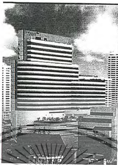
ภาพที่ 2.110 แสดงลักษณะอาคารโรงแรม เจดับบลิว แมริออท
