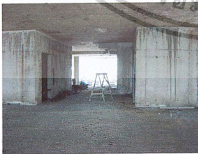
ภาพบริเวณโถงลิฟท์
