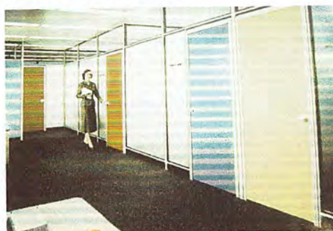
ภาพที่ 2.76 การแบ่งที่ทำงานด้านผนังสำเร็จรูป
