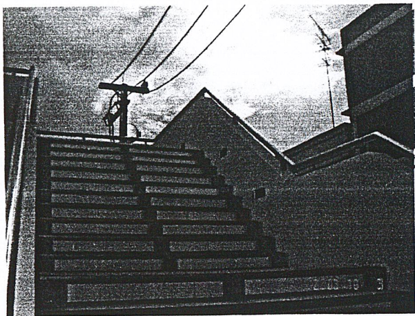
ภาพที่ 3.24 ส่วนบันไดทางขึ้นหลัก พื้น—หินล้าง กรูกระเบื้องเซรามิก/ผนัง- ก่ออิฐฉาบปูน
