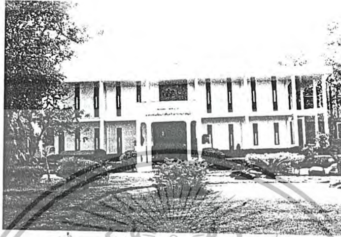
รูปที่ 48 รูปด้านหน้าอาคารด้านทิศตะวันออก
