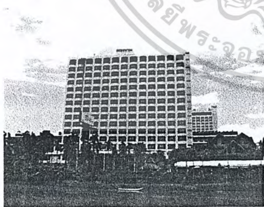
รูปที่ 161 อาคาร Hotel New Wing
