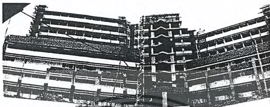
ภาพที่ 4.3-3 แสดงภาพอาคารทางด้านทิศใต้
