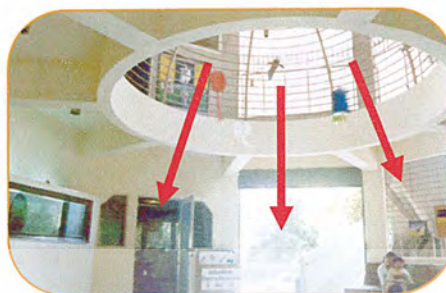
ภาพที่ 4.13 ส่วนโถงทางเข้าชั้นที่ 1 และแสดงภาพลักษณะการเจาะทะลุระหว่างชั้น 1 ถึง ชั้น 2 เพื่อให้แสงสว่างจากด้านนอกอาคารเข้าสู่ตัวอาคาร (อาคารที่ 1 ชั้นที่ 1)
