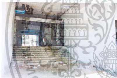
ภาพที่ 3.22 แสดงส่วนโถงทางเข้าสำรอง พื้น - หินแกรนิต, ฝ้าเพดาน - ยิปซัมบอร์ด, ผนัง - ก่ออิฐฉาบปูนเรียบ
