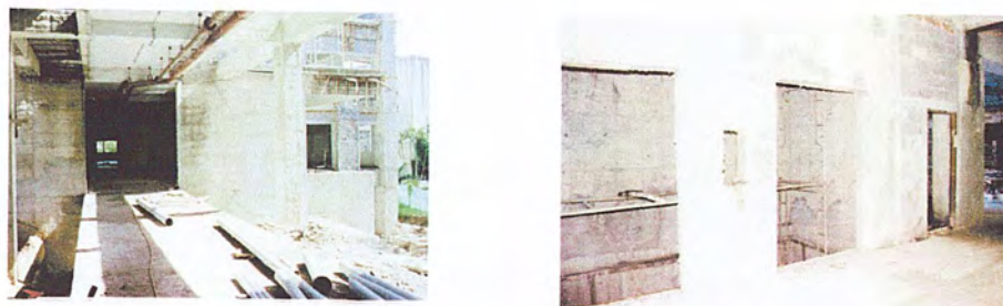
ภาพที่ 3.24 แสดงส่วนทางเชื่อมระหว่างตึกและส่วนโถงลิฟท์ พื้น - หินแกรนิต, ฝ้าเพดาน - ยิปซัมบอร์ด, ผนัง - ก่ออิฐฉาบปูนเรียบ
