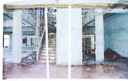
ภาพที่ 3.21 แสดงส่วนโถงทางเข้าหลักด้านทิศใต้ พื้น - หินแกรนิต, ฝ้าเพดาน - ยิปซัมบอร์ด, ผนัง - ก่ออิฐฉาบปูนเรียบ
