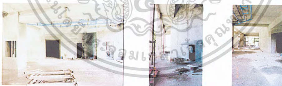
ภาพที่ 3.26 แสดงส่วนทางเข้าหลักทางทิศตะวันตกและห้องเรียนบรรยาย พื้น - หินแกรนิต, ฝ้าเพดาน - ยิปซัมบอร์ด, ผนัง - ก่ออิฐฉาบปูนเรียบ
