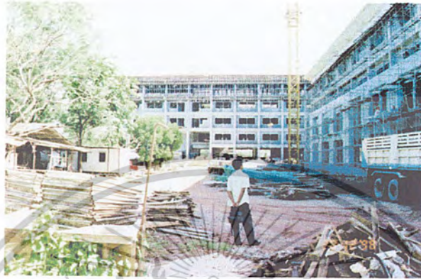
ภาพที่ 3.19 แสดงรูปด้านทิศตะวันตก ผนัง - คอนกรีต ประตู - ไม้, กระจก หน้าต่าง - กระจก
