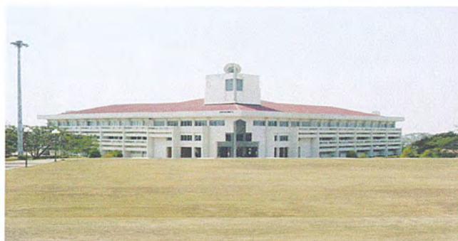
ภาพที่ 2.129 แสดงอาคารศูนย์สารบรรณ
