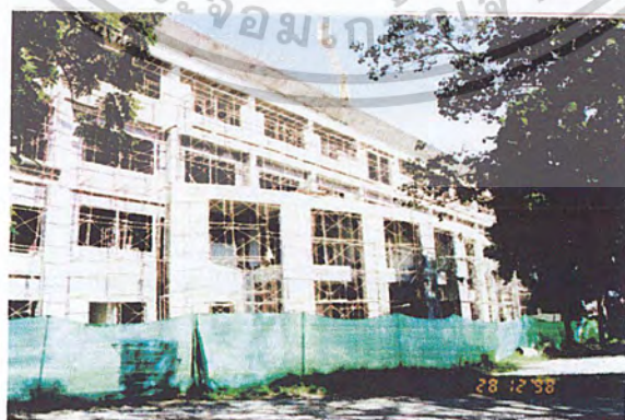
ภาพที่ 3.18 แสดงรูปด้านทิศตะวันออก ผนัง - คอนกรีต ประตูละตู้ - ไม้, กระจก หน้าต่าง - กระจก
