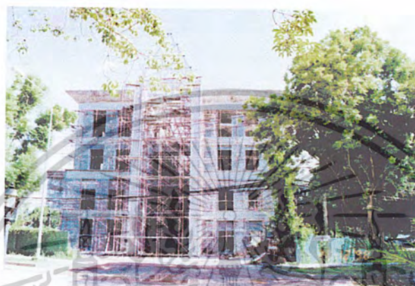
ภาพที่ 3.17 แสดงรูปด้านทิศใต้ ผนัง - คอนกรีต ประตูละตู้ - ไม้, กระจก หน้าต่าง - กระจก
