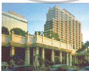
ภาพที่ 2.70 ลักษณะอาคารภายนอกโรงแรมแกรนด์ ไฮแอท เอราวัณ
