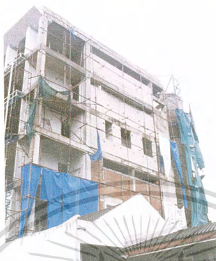
ภาพที่ 3.13 แสดงลักษณะภายนอกอาคารด้านทิศตะวันตกซึ่งติดกับบ้านพักอาศัย
