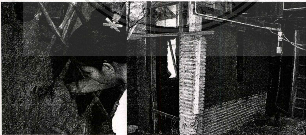
ภาพที่ 2.11 แสดงลักษณะการทำผนังด้วยเทคนิคโครงไม้ผสมดิน (Wattle and Daub)
