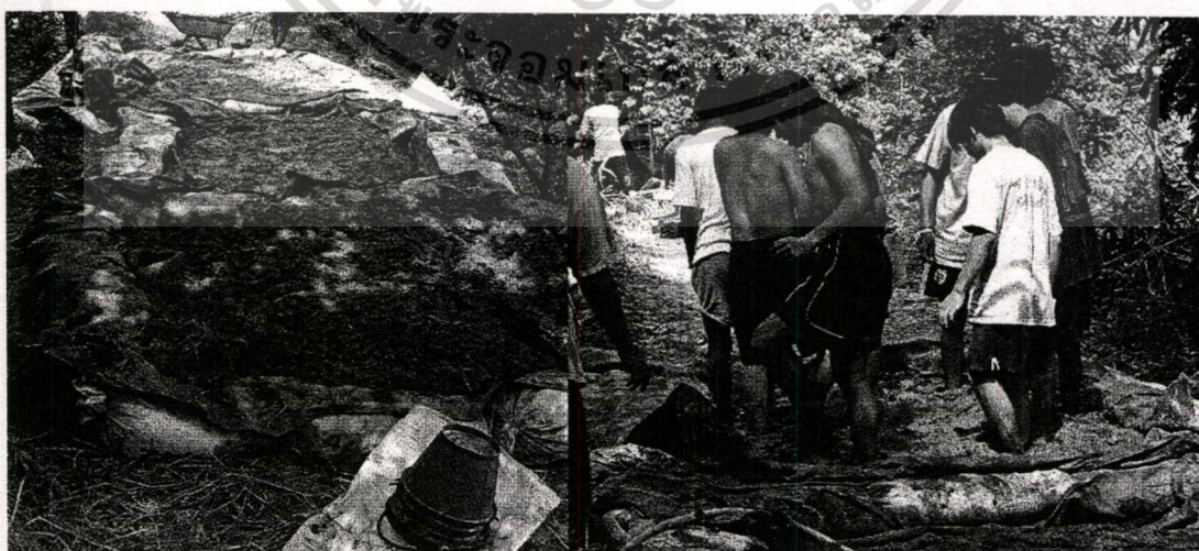
ภาพที่ 2.4 แสดงการเตรียมบ่อหมักดิน และการย่ำดินเพื่อใช้ในการทำอิฐดิน
