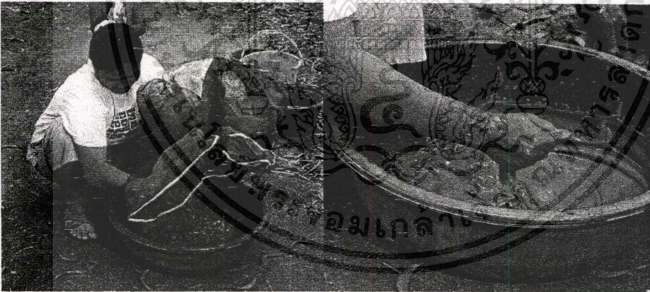
ภาพที่ 2.17 แสดงการผสมดินสำหรับการทาสีผนัง
