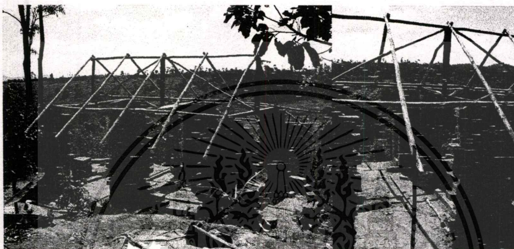
ภาพที่ 2.12 แสดงการวางโครงหลังคาของบ้านดิน
