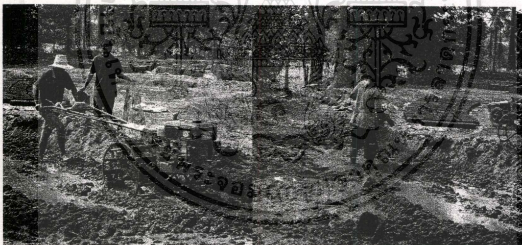
ภาพที่ 2.5 แสดงการย่ำโดยใช้อุปกรณ์ในการทำนาและการโรยฟางสับเพื่อให้ดินเกิดความเหนียว ที่มา : จากการสำรวจครั้งที่ 1 ปี 2545
