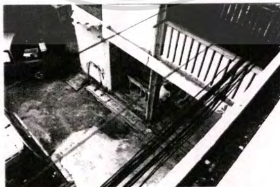
ภาพที่ 4.23 แสดงรูปถ่ายรางระบายน้ำตรงทาง เดินหน้าห้องพัก
