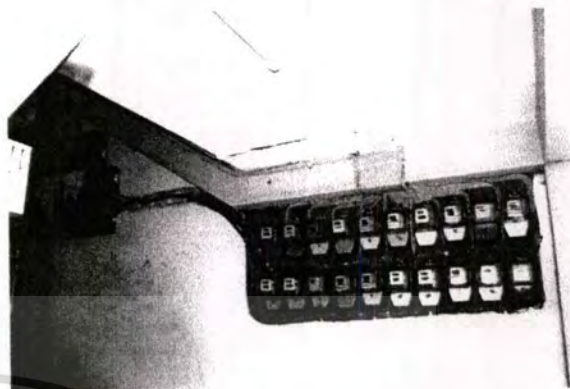
ภาพที่ 4.15 แสดงรูปถ่ายมิเตอร์ไฟฟ้าตงบันได หลัก
