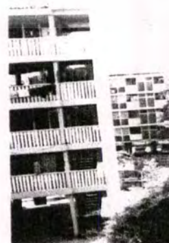
ภาพที่ 4.18 แสดงรูปถ่ายภายนอกบันไดหนีไฟ
