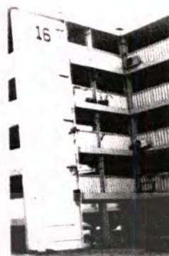
ภาพที่ 4.25 แสดงรูปถ่ายภายนอกโถงบันได
