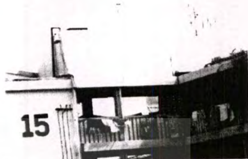
ภาพที่ 4.40 แสดงรูปถ่ายถังเก็บน้ำชั้นดาดฟ้า
