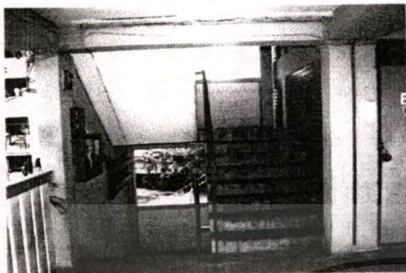
ภาพที่ 4.14 แสดงรูปถ่ายภายในบันไดหลัก
