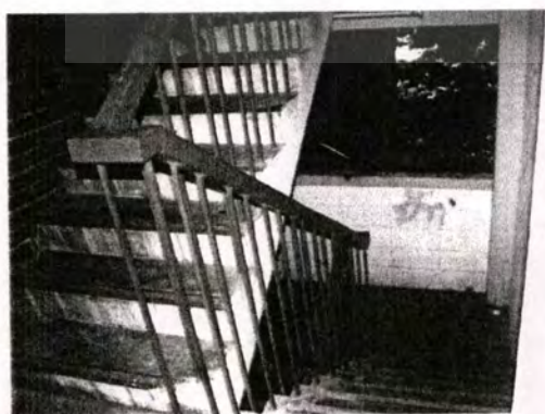
ภาพที่ 4.17 แสดงรูปถ่ายภายในบันไดหนีไฟ
