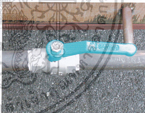
รูปที่ 3.5 วาล์วควบคุมทิศทางการไหลของน้ำ
