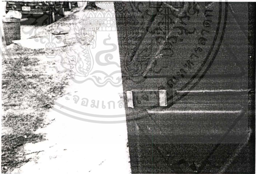
ภาพที่ ก6 แสดงส่วนล็อกบานประตู เปิด - ปิด โดยวัสดุที่ใช้เป็นไฟเบอร์กลาส เป็นโครงสร้างส่วนประกอบ
