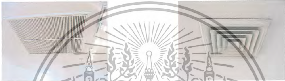
หน้ากากจ่ายลมเย็นซึ่งภายในจะมีเครื่องทำความเย็นซ่อนอยู่ใต้เพดาน
