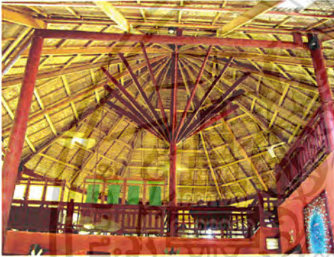
ภาพที่ 2.69 แสดงโครงสร้างหลังคา
