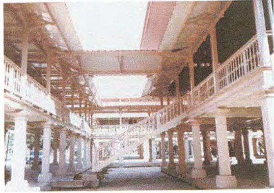
ภาพที่ 172 ลักษณะทางเชื่อมต่อระหว่างพระที่นั่ง ด้านบนเปิดรับแสงจากธรรมชาติทำให้บรรยากาศดูปลอดโปร่ง
