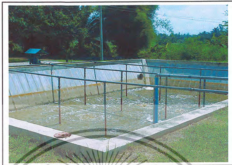
ภาพที่ 2.11 บ่อดกตะกอน (Sedimentation pond)
