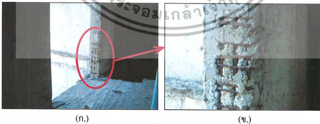
รูปที่ 4.77. แสดงสภาพเหล็กเสริมบริเวณช่องบันไดเวียน
