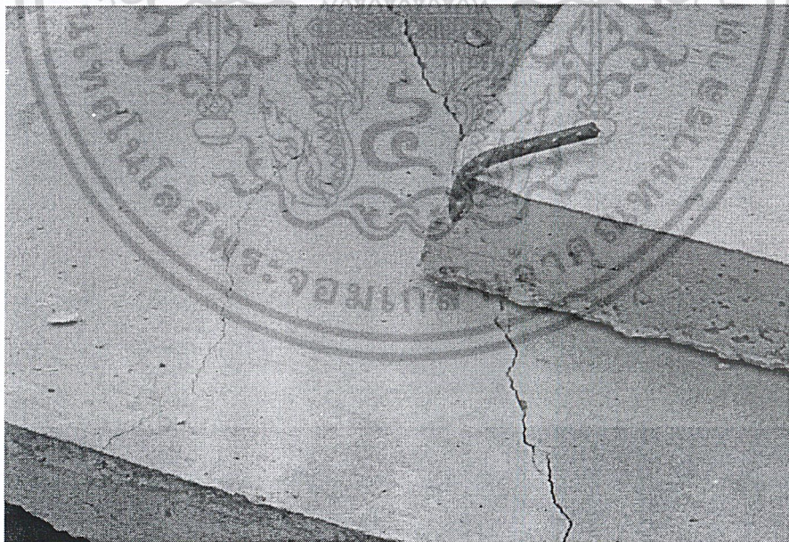
รูปที่ ผ.ก2.16 แผ่นคอนกรีตแตกร้าว
