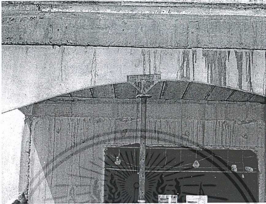
รูปที่ ผ.ก1.17 ค้ำยันเพื่อไว้หลังจากเอาค้ำยันทั้งหมดออก เพื่อให้คอนกรีตค่อยๆรับน้ำหนัก
