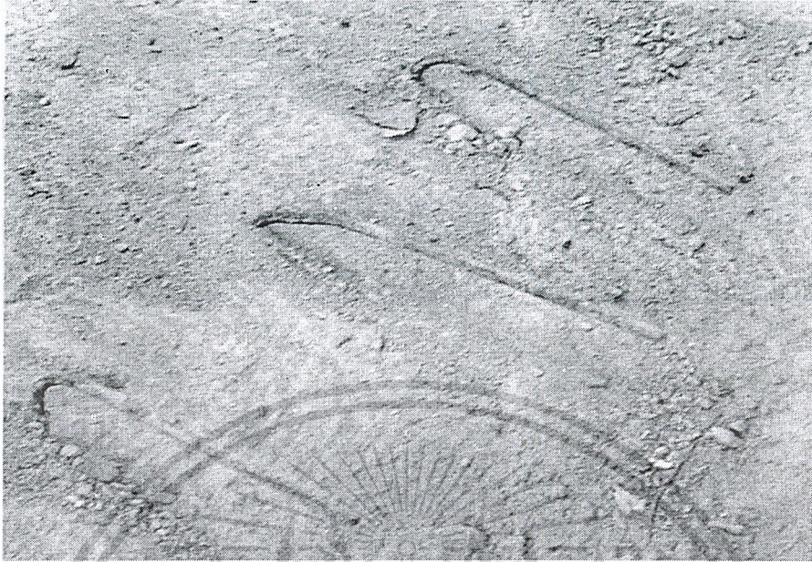
รูปที่ ผ.ก1.9 เหล็กโดเวลสำหรับยึดกับชิ้นส่วนที่จะมาติดตั้ง
