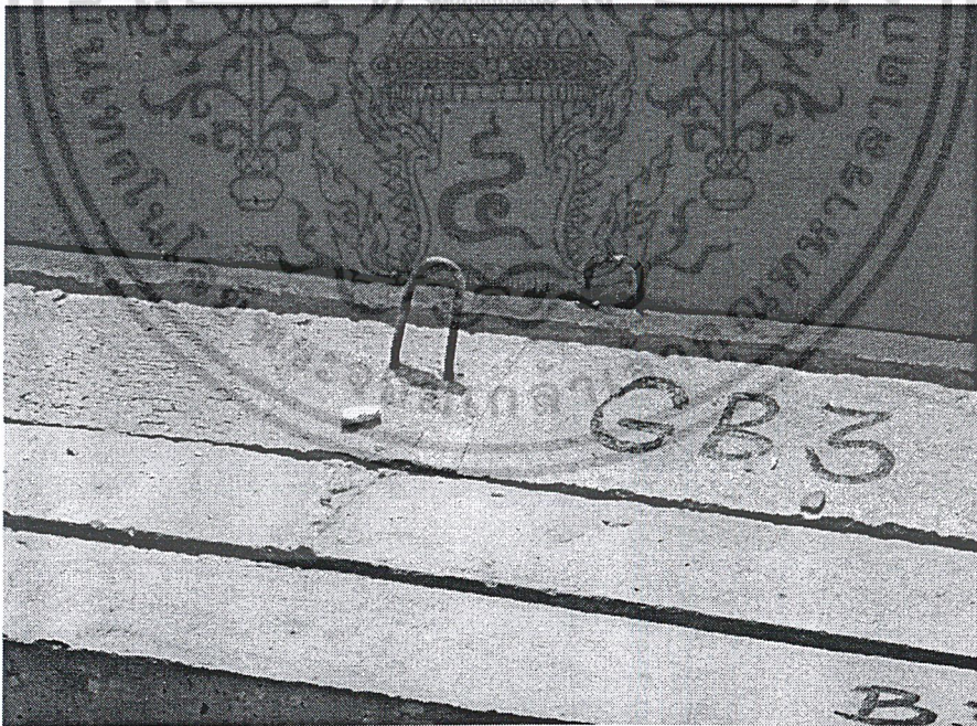
รูปที่ ผ.ก1.14 เหล็กเสียบไว้เพื่อช่วยในการยก
