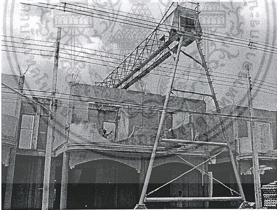
รูปที่ ผ.ก1.4 เกรนสำหรับยกชิ้นส่วนสำเร็จรูปติดตั้ง
