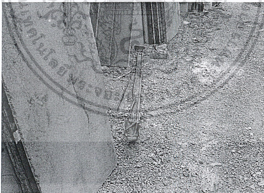
รูปที่ ผ.ก2.12 ชิ้นส่วนแบบหล่อที่ชำรุด
