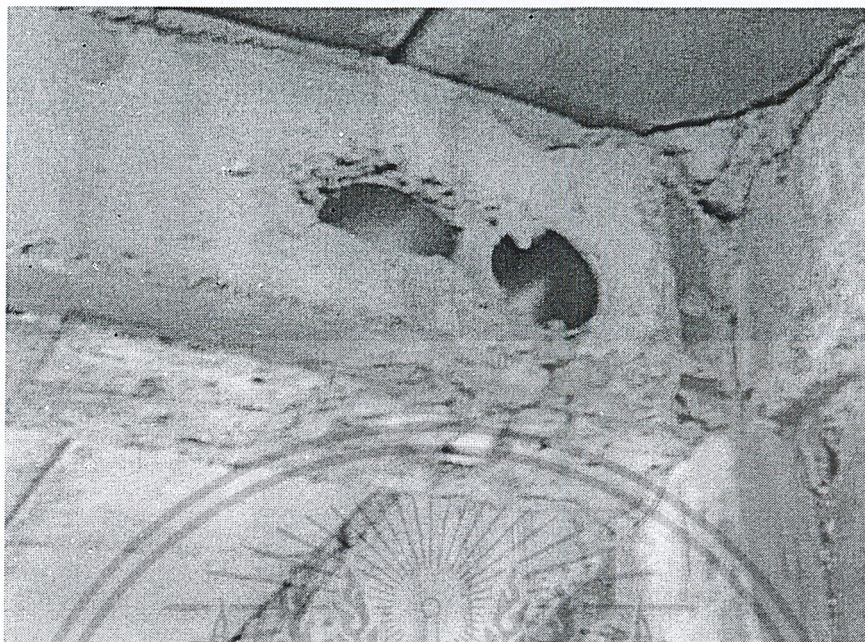
รูปที่ ผ.ก1.7 ท่อฝังในคานเพื่อเป็นช่องลอด เช่น สายไฟฟ้า
