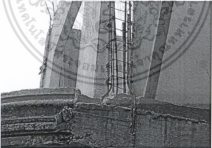
รูปที่ ผ.ก2.6 เหล็กแกนเสาไม่ได้ตำแหน่ง
