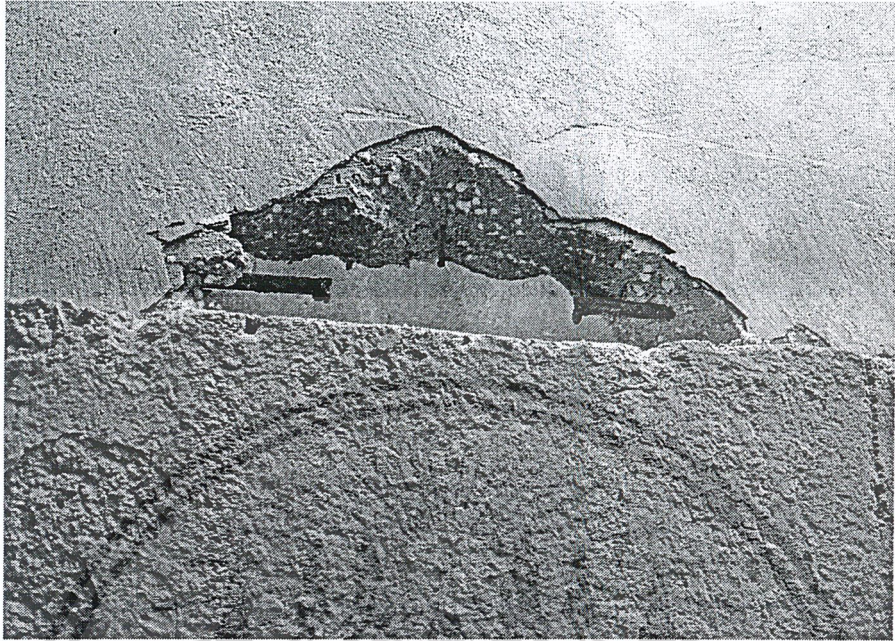
รูปที่ ผ.ก2.9 เจาะเพื่อเป็นช่อง เช่นช่องระบายน้ำ
