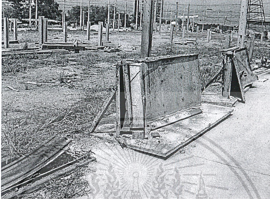
รูปที่ ผ.ก2.11 แบบหล่อที่เกิดความเสียหาย
