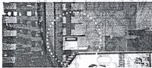
ภาพ แสดงส่วนเครื่องอ่านบัตรซึ่งมีหน้าที่เปิดประตู สำหรับภายในสำนักงานเข้าตามหน่วยงานหรือห้อง ต่างๆภายใน - เครื่องอ่านบัตรทำหน้าที่อ่านและเขียนข้อมูลลงไปที่ แถบบัตร
