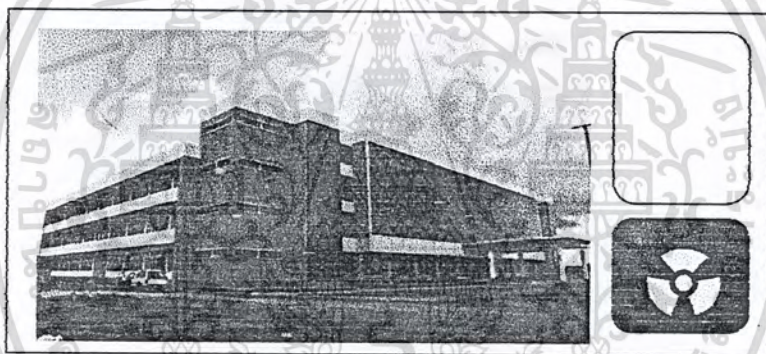
ภาพที่ 3.6 อาคารสำนักงานพลังงานปรมาณูเพื่อสันติ ศูนย์วิจัยนิวเคลียร์องครักษ์
