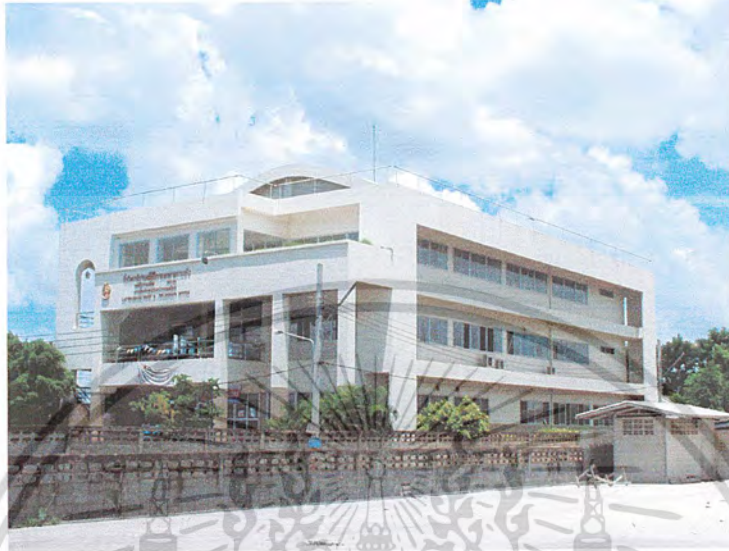
ภาพที่ 2.103 แสดงลักษณะของอาคารที่ทำการไปรษณีย์ ลาดกระบัง
