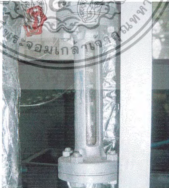
รูปที่ 6.5 โรตาริเตอร์วัดอัตราการไหลของน้ำร้อนและน้ำเย็น
