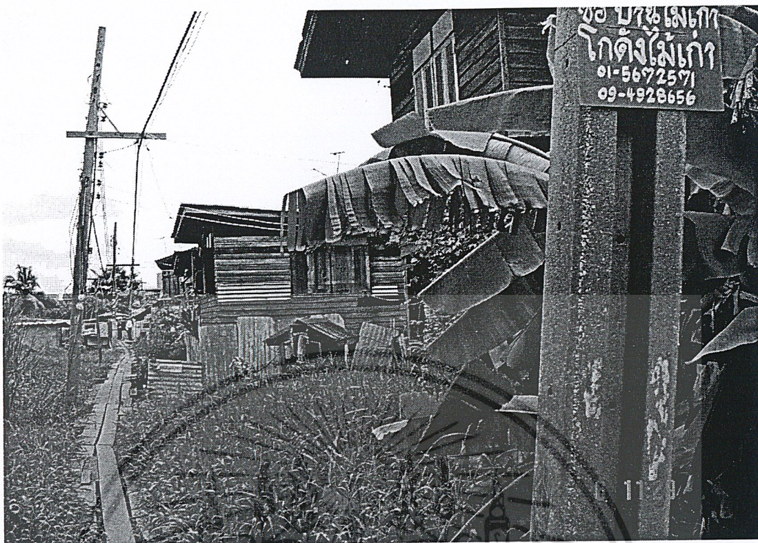
รูปที่ 2.2.53. เสาไฟฟ้าบริเวณชุมชนถนนปู่เจ้าสมิงพราย (Dwg. No. MEA-CT1-6)
