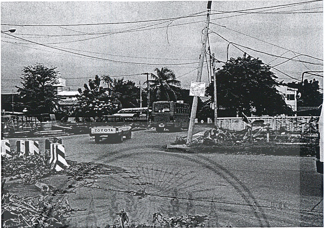
รูปที่ 2.2.47. เสาไฟฟ้าบริเวณท่าเรือเกตรา (Dwg. No. MEA-CT1-2)
