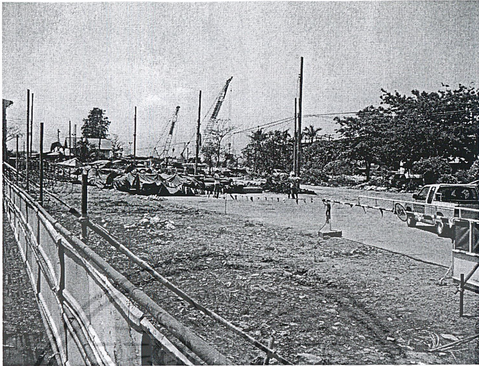
รูปที่ 4.17. พื้นที่บริเวณทางเข้าท่าเรือเกตรา- (Dwg. No. -CT1-4)
