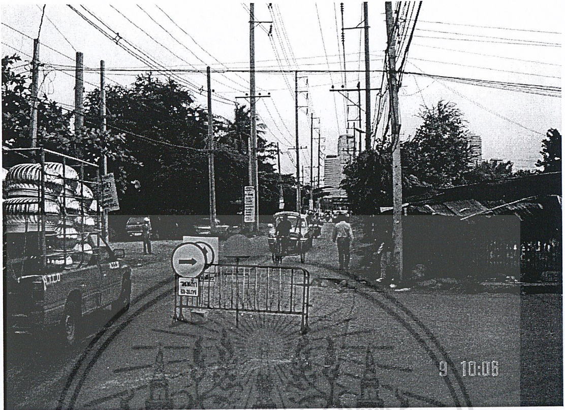
รูปที่ 2.2.45. เสาไฟฟ้าบริเวณแยกถนนนครเขื่อนขันธ์ (Dwg. No. MEA-CT2-17)
