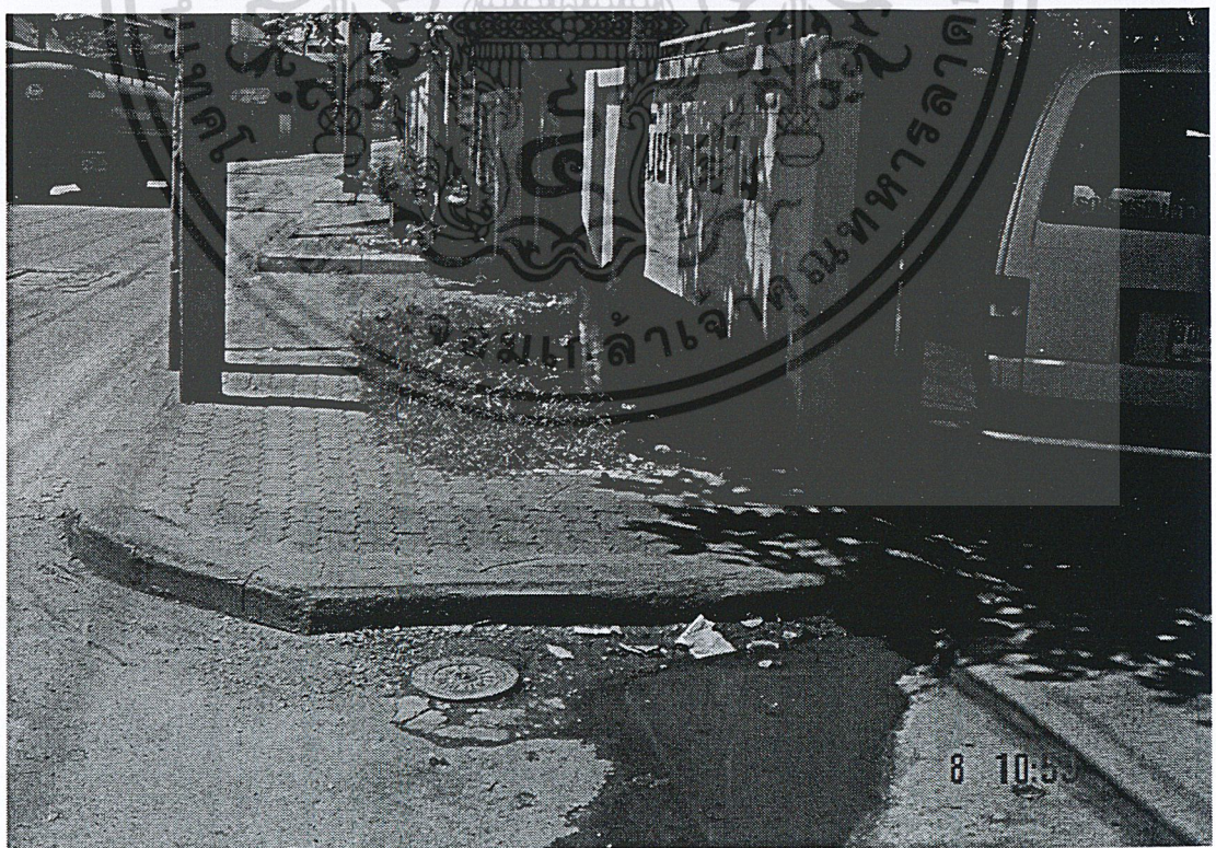
รูปที่ 2.3.36. บ่อพักท่อน้ำประปาบริเวณถนนนครเขื่อนขันธ์ (Dwg. No. MWA-CT1-1)
