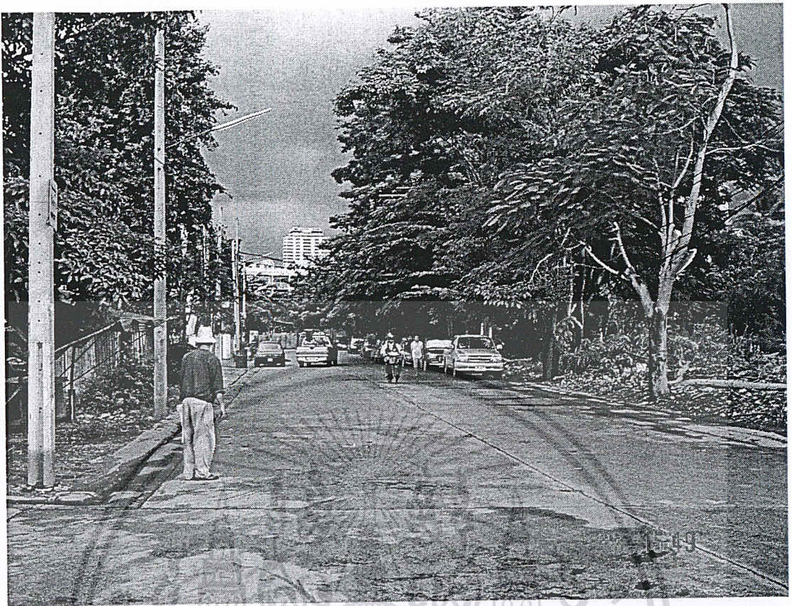
รูปที่ 2.2.39. เสาไฟฟ้าบริเวณซอยสาธุประดิษฐ์ 53 (Dwg. No. MEA-CT2-06)
