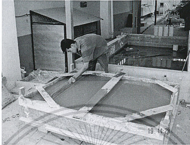
รูปที่ ผ.ข.13 แสดงการฉาบหน้าผิวคอนกรีตให้เรียบและได้ระดับ
