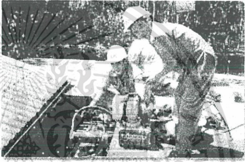
ขั้นตอนที่ 7 ค้ำยันและไม้แบบ สามารถถอดได้หลังจาก Stressing เสร็จเรียบร้อยแล้ว
