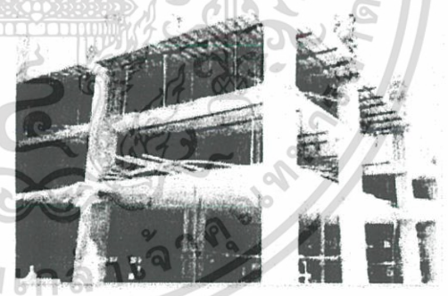
ขั้นตอนที่ 8 Grouting ด้วยน้ำปูน (กรณี Bonded Tendon )
