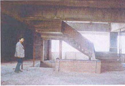
โถงบันไดหลัก
