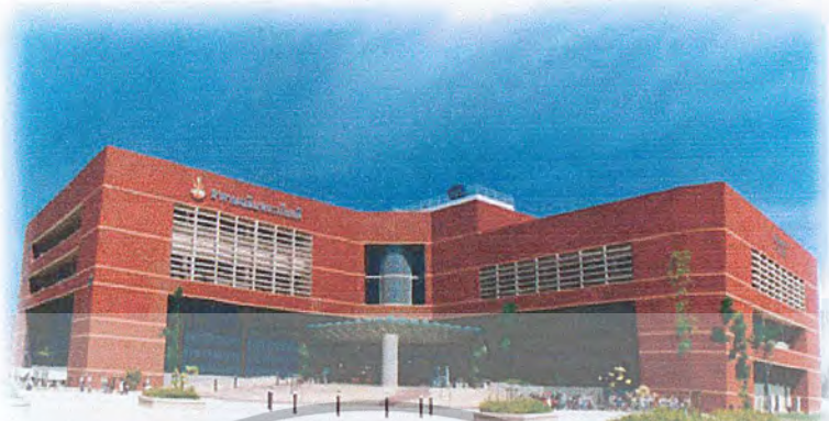
ภาพที่ 2.73 แสดงทัศนียภาพภายนอกสำนักหอสมุดกลาง(อาคารเฉลิมพระเกียรติ) สถาบันพระจอมเกล้าเจ้าคุณทหารลาดกระบัง
