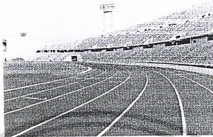
รูปที่ 3.22 แสดงพื้นที่ข้างสังเคราะห์ที่มีความยืดหยุ่นคือยาง Rrkoryan polyurethane
