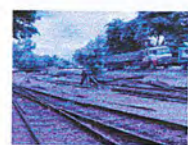
ถนนไม่มีทางเท้า
