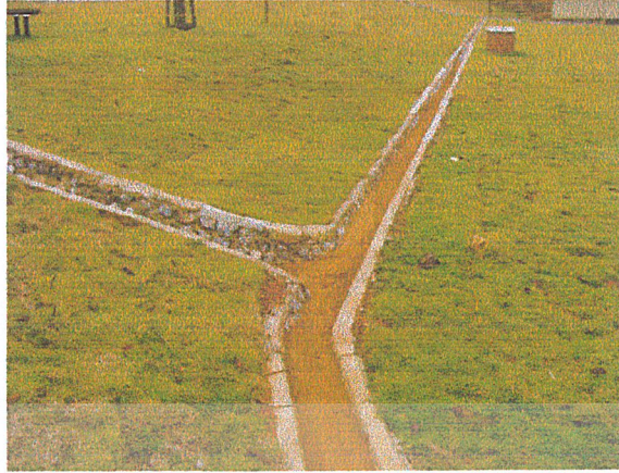
รูปที่ 3.14 แสดงรางระบายน้ำหินก่อ ซึ่งมีที่วบริเวณลานกลางเต็นท์
