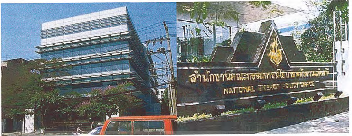
ภาพที่ 2.29 แสดงรูปด้านหน้าของตัวอาคารซึ่งติดกับถนนเพชรบุรี
