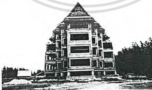
ภาพที่ 3.14 รูปด้านทางทิศใต้ ผนัง-คอนกรีต ประตู-อลูมิเนียม กระจก หน้าต่าง-อลูมิเนียม กระจก
