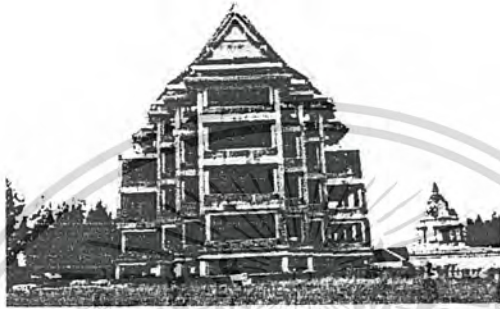
ภาพที่ 3.13 รูปด้านทางทิศเหนือ ผนัง-คอนกรีต ประตู-อลูมิเนียม กระจก หน้าต่าง-อลูมิเนียม กระจก
