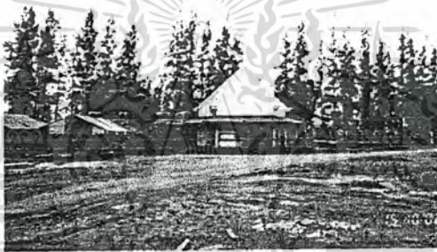
ภาพที่ 3.5 ทิศใต้ติดกับสำนักงานชั่วคราว
