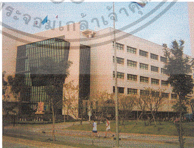
รูปที่ 3.9 ลักษณะการตกแต่งของตัวอาคาร
