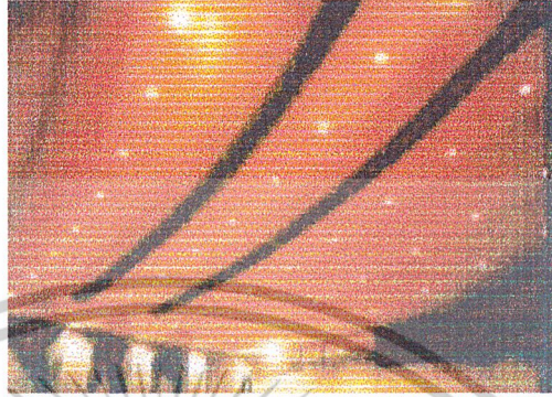
รูปที่ 3.21 แสดงการออกแบบเพดานโค้งเป็นลอนเพื่อผลในการกระจายของเสียง ภายในการจัดระบบแสงสว่างและระบบปรับอากาศภายใน ที่มาจากหนังสือ Art 4 D
