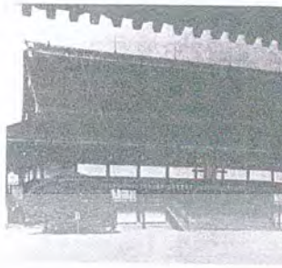
รูปที่ 2.15 อาคารชิน
