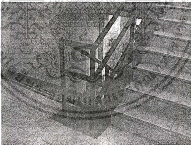
ภาพที่ 4.126 แสดงบันไดหลักและบันไดบริการเพราะออกแบบให้มีขนาดและความสำคัญ เท่ากันพื้นผิวปูกระเบื้องเคลือบและมีมุกบันได P.V.C. ผึง
