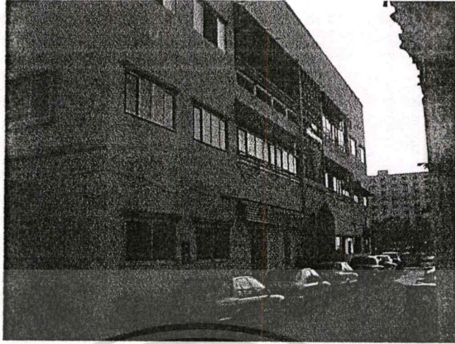
ภาพที่ 4.17 แสดงด้านหน้าอาคารเรียนที่ไม่มีการจัดสวนหย่อม และการปลูกต้นไม้ใหญ่ อีกทั้งทางเดินเท้า และถนนด้านหน้าอาคารเป็น ค.ส.ล. ทำให้ส่งผลกระทบต่อเรื่องการแผ่ความร้อนเข้ามาภายในอาคารเรียน
