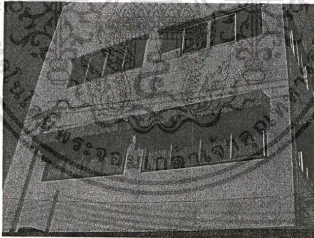
ภาพที่ 4.14 แสดงกันสาดอะลูมิเนียม โครงเหล็กด้านข้างอาคารเรียนสถาปัตยกรรมเพื่อป้องกัน แดด ฝน
