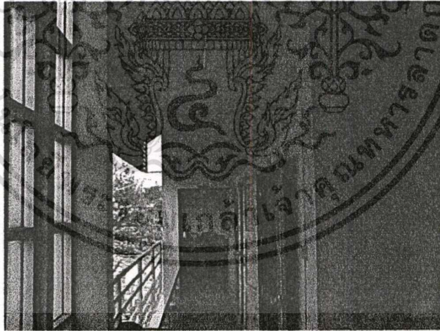
ภาพที่ 4.25 แสดงแผงกันสาดอะลูมิเนียมป้องกันแดด ฝน ความร้อนด้านหน้าอาคารเรียน บริเวณโถงทางเดินหน้าห้องเรียนบรรายายชั้น 3
