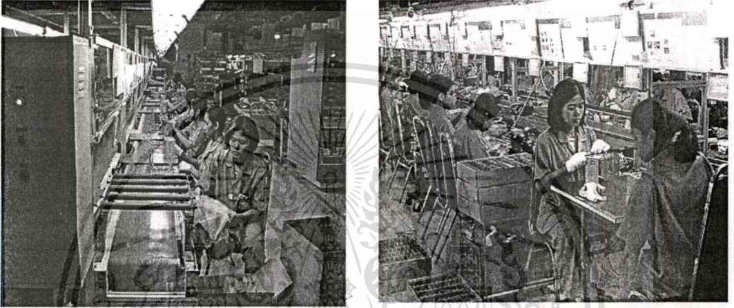
รูปที่ 5.1 การจัดสายการประกอบพัสดุก่อนและหลังการปรับปรุง
