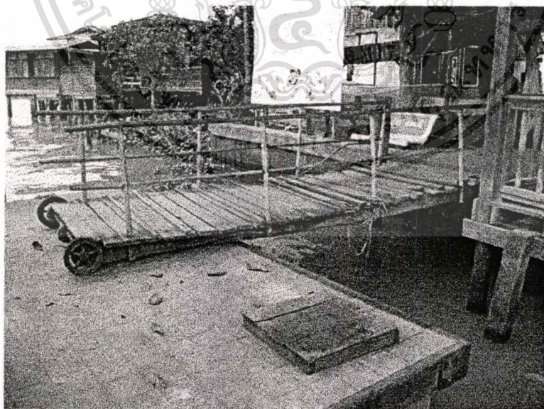
ภาพที่ 4.39 แสดงทางขึ้นลงที่ชำรุดเสียหาย ที่มา : จากการสำรวจเดือนมกราคม 2545
