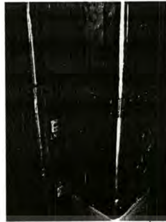
ภาพที่ 3.9 แสดงการทำช่องท่อฝังดินโดยใช้ปิ๊ป ด้านซ้ายแสดงการฉีกตัวปิ๊ปออกเพื่อเปิดรับท่อสังกะสี ด้านขวาแสดงการเชื่อมต่อระหว่างปิ๊ปด้วยรีเวท
