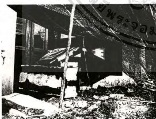
ภาพที่ 3.64 หลังจากเดินท่อและทากันซึม(ฟิล์มโค้ท) และ การปิดหน้าต่างในหน่วยทดสอบที่ 1 ด้วยโฟม 3 นิ้ว
