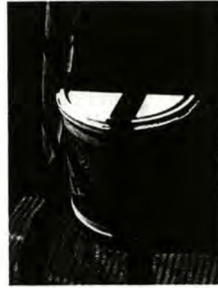
ภาพที่ 3.8 การเชื่อมต่อท่อ โดยใช้ผ้าดิบที่ทากันซึมจนผ้าเป็นสีดำ แต่ถูกฝนชะออกจนสีผ้าเกือบเหมือนเดิม และ ยาทากันซึม
