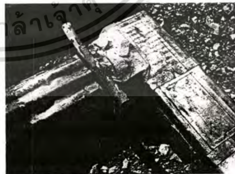
ภาพที่ 3.10 การเชื่อมต่อท่อสังกะสีลอนกับช่องอที่ใช้ปิ๊ปทำ โดยทำการอุดร่องตามรอยต่อโดยใช้ผ้าและยาทากันซึม
