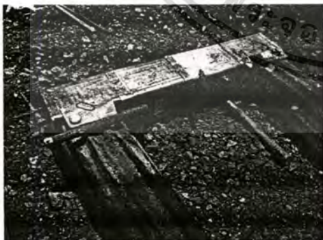
ภาพที่ 3.10 การเชื่อมต่อท่อสังกะสีลอนกับช่องอที่ใช้ปิ๊ปทำ โดยทำการอุดร่องตามรอยต่อโดยใช้ผ้าและยาทากันซึม
