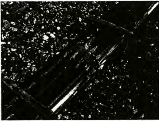
ภาพที่ 3.8 การเชื่อมต่อท่อ โดยใช้ผ้าดิบที่ทากันซึมจนผ้าเป็นสีดำ แต่ถูกฝนชะออกจนสีผ้าเกือบเหมือนเดิม และ ยาทากันซึม
