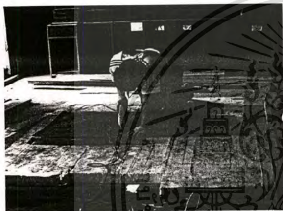
ภาพที่ 3.40 เครื่องมือที่ใช้ในการตัดตัวซ้ายมือมีกำลังที่ 250 watt กำลังเครื่องไม่พอต้องเปลี่ยนเครื่องเป็น ตัวขวามือ มีกำลัง 380 watt แทน
