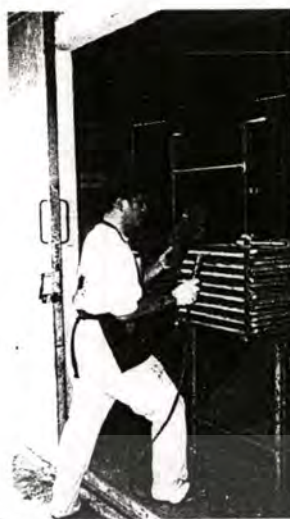
ภาพที่ 3.51 การเชื่อมต่อโครงสร้างกับถาดสังกะสีและ การเชื่อมเหล็กฉากเพื่อบับช่องเป็ยก และแห้งให้ติดกับโครงสร้างที่เป็นเหล็ก
