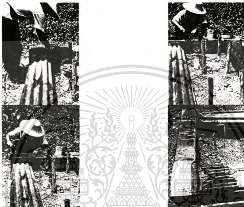
ภาพที่ 3.11 ขั้นตอนการทำงานนำยาทายากันซีมหลังจากการเชื่อมต่อท่อกับช่องอโดยการทายากัน ซีมก่อนตัดตั้งลงพื้น
