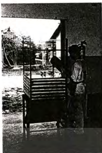
ภาพที่ 3.51 การเชื่อมต่อโครงสร้างกับถาดสังกะสีและ การเชื่อมเหล็กฉากเพื่อบับช่องเป็ยก และแห้งให้ติดกับโครงสร้างที่เป็นเหล็ก
