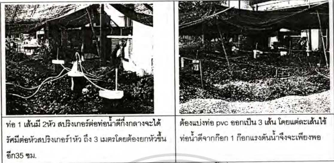
ภาพที่ 3.76 แสดงปัญหาและการแก้ไขเรื่องแรงดันน้ำที่ให้กับระบบท่อฝังดิน
