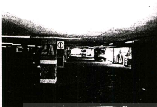
ภาพถนนภายในบริเวณที่จอดรถ
