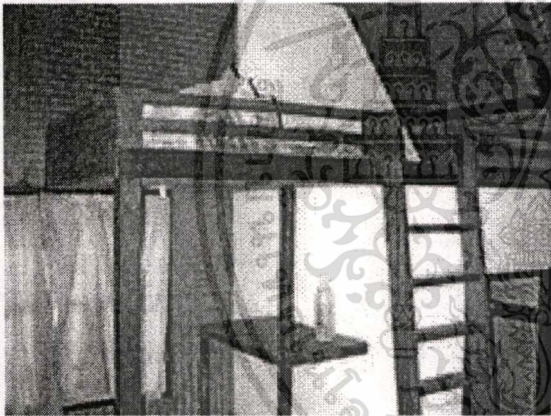
รูปที่ 3.94 แสดงบันไดทางขึ้นที่นอนเหนือห้องน้ำ
