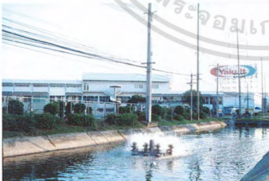
รูปที่ 7.11 ติดกับโรงงาน ยาकुทธ์ทางด้าน ทิศเหนือ
