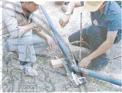
รูปที่ 2.10 ลักษณะขั้นตอนการถ่ายภาพด้วยรังสีแนวเชื่อมท่อน้ำมันภาคสนาม
