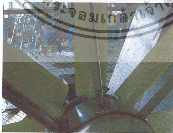
รูปที่ 4-15 Guide Vane แบบที่ 1
