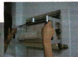
8. นำเครื่องตีวอลเปเปอร์ขึ้นติดตั้ง
