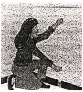
ภาพที่ 2.20 แสดงภาพการตีแนวคั้งคิ้ววอลล์เปเปอร์
