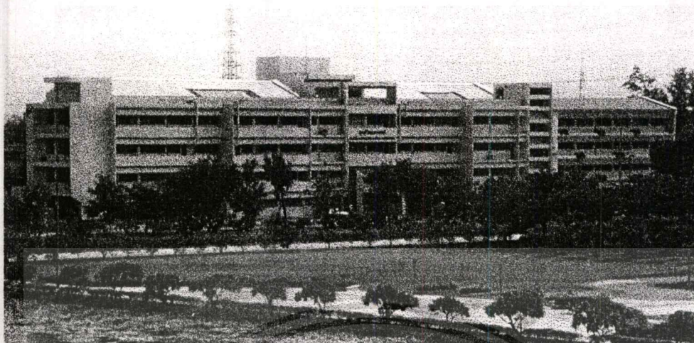
ภาพที่ 4.17 ด้านหน้าอาคารศูนย์วิทยาศาสตร์ (อยู่ด้านข้างอาคาร 15 ชั้น)
