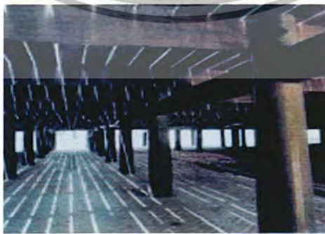
รูปที่ 1.4 ภาพแสดงโครงสร้างส่วนล่างของเรือนเครื่องสับเรียกว่า คานหรือรอด
