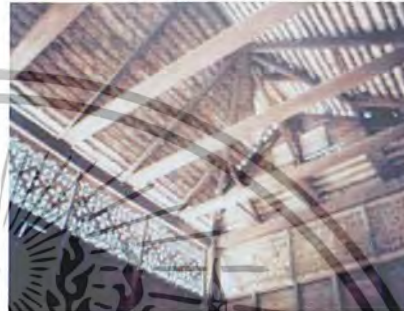
รูปที่ 1.6 ภาพแสดงการเข้าไม้ในส่วนหลังคา เรียกว่า เครื่องบน
