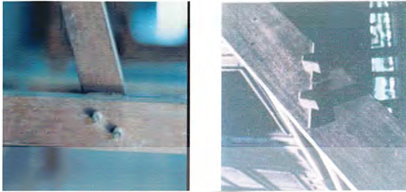
รูปที่ 2.4 ภาพแสดงการเข้าเดือยกลมและเหลี่ยม
