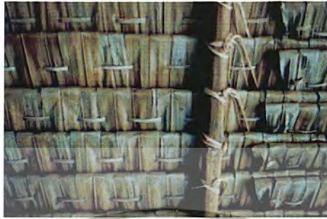
รูปที่ 1.2 ภาพแสดงการผูกมัดส่วนหลังคาของเรือนให้ยึดติดกัน
