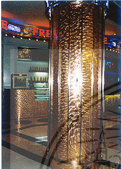
การตกแต่งผนังเสาด้วยแผ่นทองแดง และทำการขัด เพื่อให้เกิดลวดลายของ โรงภาพยนตร์เมเจอร์ซีนีเพล็กซ์ ( Major Cineplex ) สาขาเสรีเซ็นเตอร์
